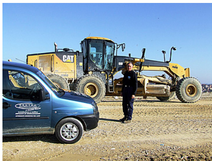
Interventi a domicilio entro 24h
